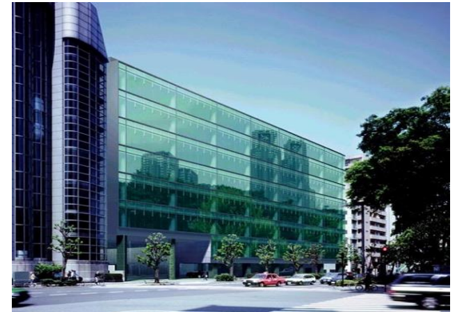
都市型データセンター
